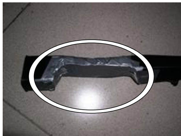
Загерметизировать воздуховод армированным скотчем (не изолянткой!!!)
