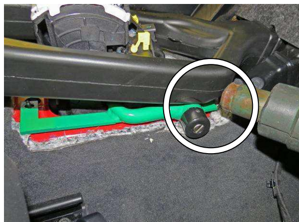
Подогреть воздуховод феном, сформировать по месту выемку под корпус замка
