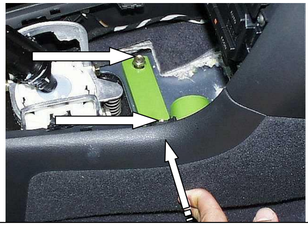
Установить замок на шпильки, закрутить 2 срывные гайки (не срывать!!!), разметить точку сверления консоли
