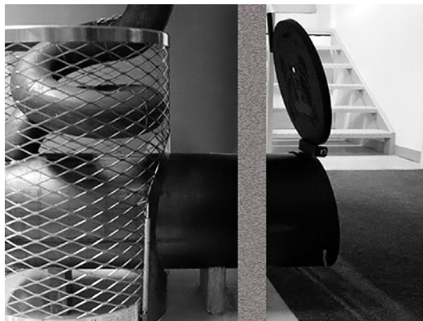
6. Проверьте горизонтальное положение топки. Откиньте дверцу назад. Установите дымоход.
