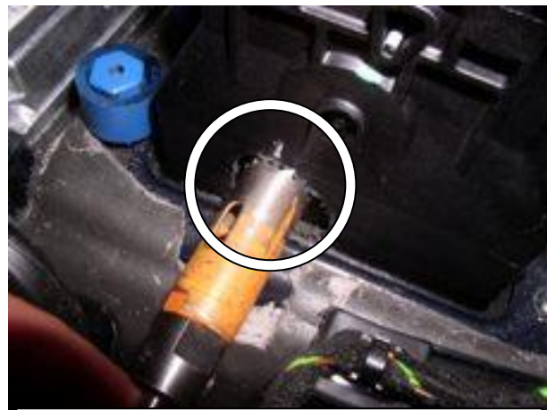
Снять замок, просверлить отверстие
